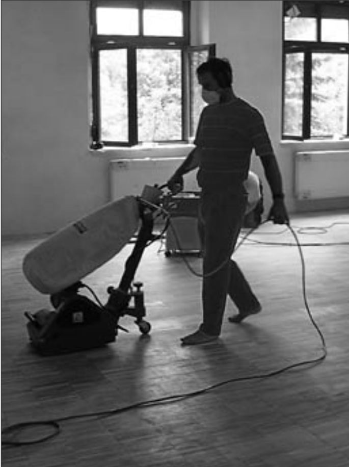
Letzte Arbeiten in der Grundschule...
